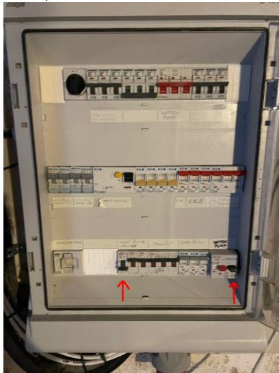
Figur 1 En av faserna i källaren på Huvudcentralen har gått, varpå vattenspumpen har stannat. Efter återställning av fasproppen måste vattenspumpen återställas med den svarta tryckknappen.
