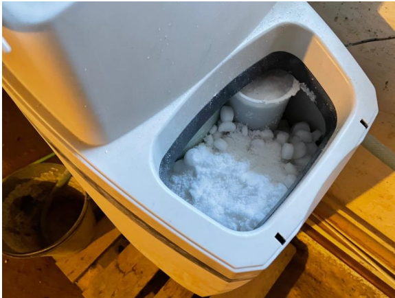
Figur 3 Behållaren för salt i avsaltningsmaskinen som fastighetsgruppen ansvarar för.
